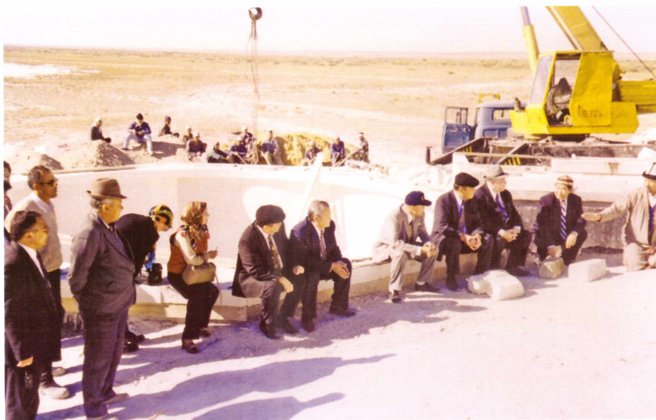
Строительство новой мечети
